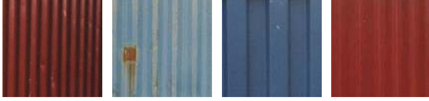
Resim-5/A Konteyner Duvarında Kullanılan Oluklu Sac Örnekleri
